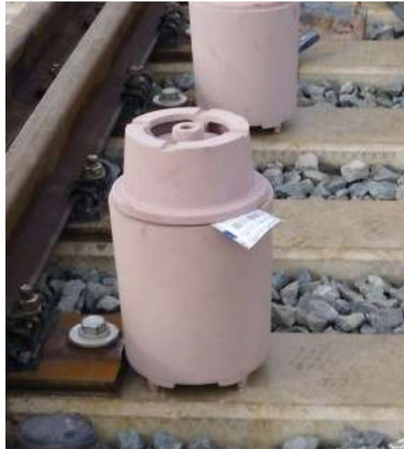
**Figura 11. Crisol de un solo uso.**
