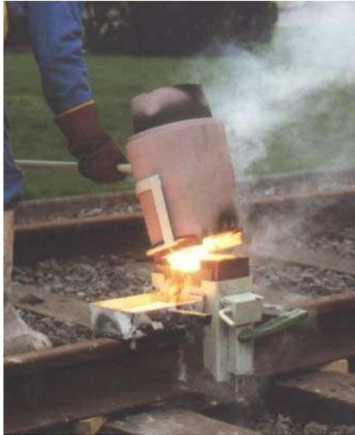
**Figura 15. Retirada del crisol**
