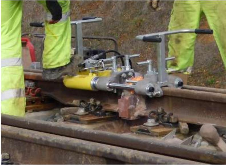
Figura 16. Rotura del molde con cortamazarotas.
